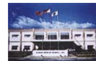
Hitachi Air Conditioning, Филиппины
